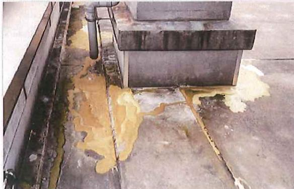
ナルライト注入工法は、注入液に圧力をかけて防水層内部へ注入します。従って、シンダーコンクリートの状態によってはひび割れ（クラック）、目地部、切り付け部等から注入液が流出します。
