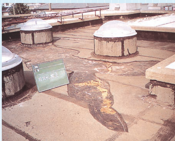
① 下地処理 旧防水層の部分撤去
