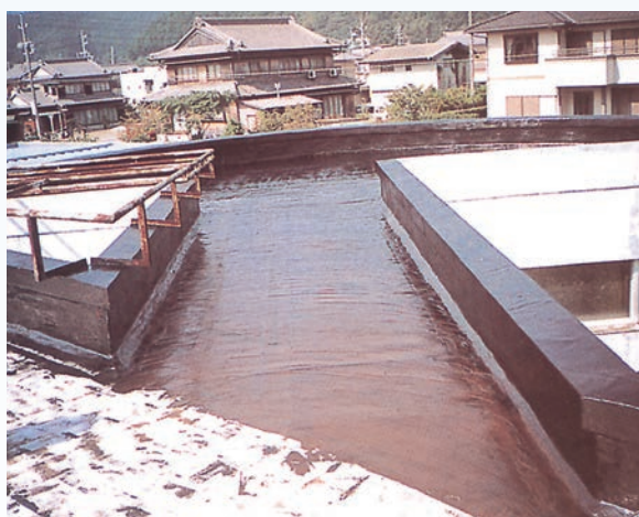
⑤ 防水剤塗布 ナルファルトWP を 1,200g/m 2 塗布
